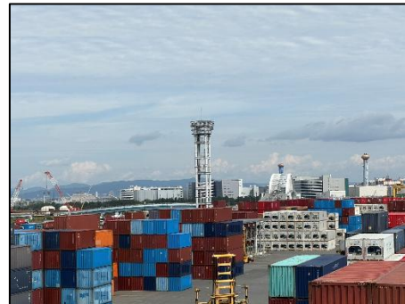
コンテナヤード内 照明塔のLED化
