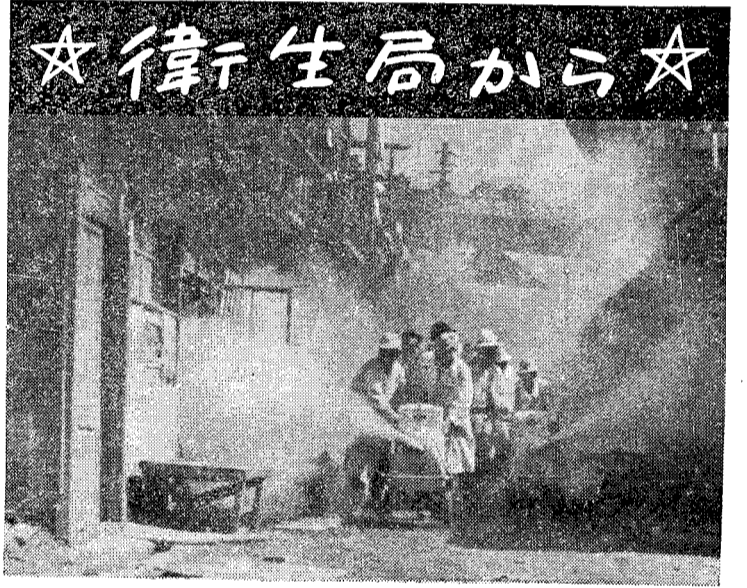
★ 衛生局から ★ ジェーン台風の被害 (九月一七日調) 倒壊家屋 二六、九五一戸 浸水家屋 一〇、一六六戸 罹災者 四四三、一三一人 といふと、これだけでも、大変な数字です。まして、瓦がとんだり、塀が倒れたり、被害は大なり小なり、全域にわたっているほか、工場設備や商品の損害や、公共施設の被害を併せ考えますと、『損害実は一千万円』といつても決して言いすぎではありません。ところが、このようなひどい災害にもかゝらず、救援作業や応急復旧が、非常に順調に捗つたのは、全く市民の一人々々が勇敢に復興に立ち上られたのと、日赤奉仕団・PTA・婦人会・青年会・水防組合その他団体の方々が、私事を捨て、日夜、救助隊の活動に御協力くださった賜です。
