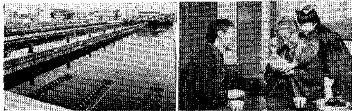
処理能力27万人分の市岡下水処理場通水、港方面の下水処理 4月
