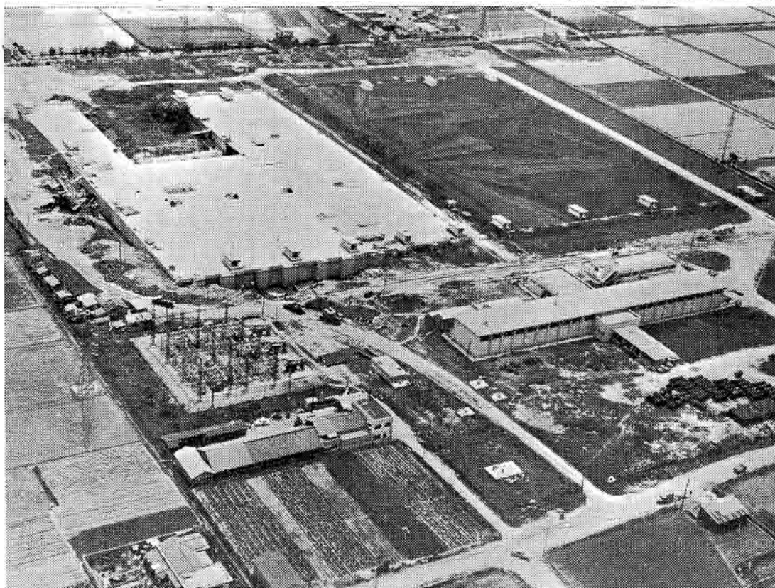
7拡完成の異配水場(右上は6拡施設)
