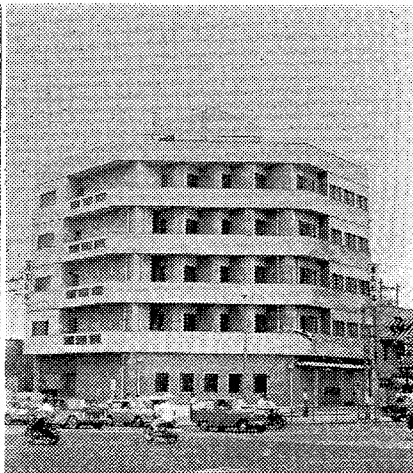
阪堺線南霞町駅前に改装中の愛隣寮
