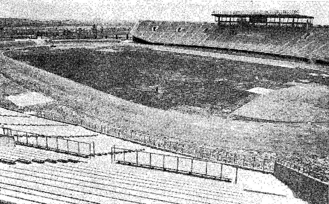
開場待つ長居公園の新設陸上競技場
