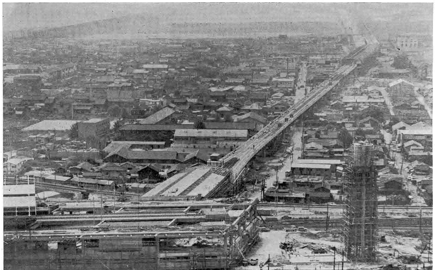
完成近い地下鉄1号線新大阪駅付近。手前左よりに国鉄新幹線ホーム、向う側が新淀川新橋
