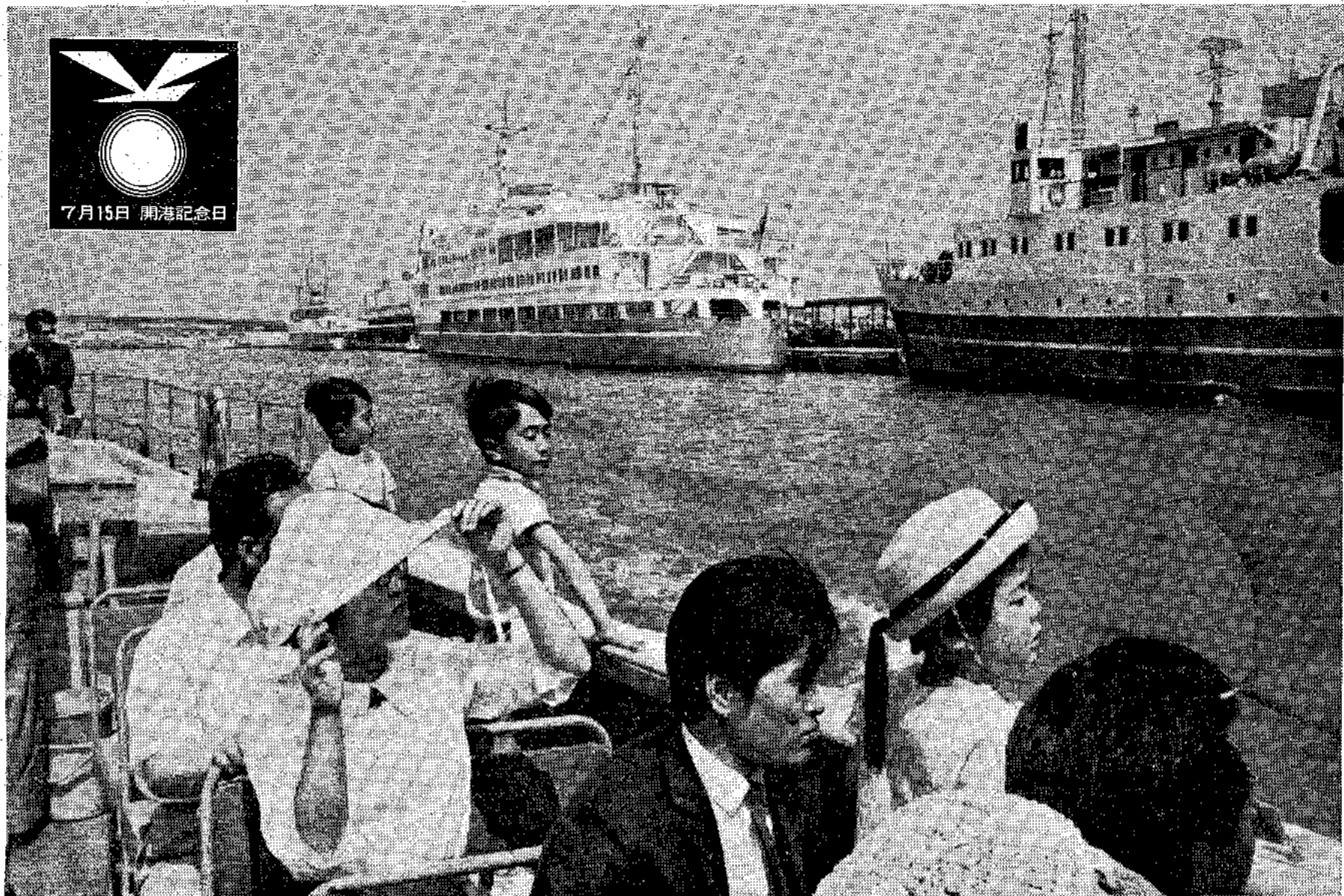
天保山さん橋に代わって安治川内港の奥に新しくできた弁天ふ頭付近（観光船から）
