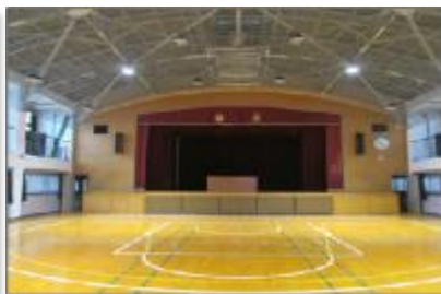
ブレース設置（屋根面）
