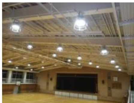
<脱落対策後> 天井撤去による対策
