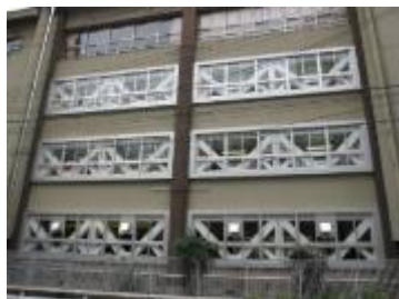
ブレース設置（窓面）
