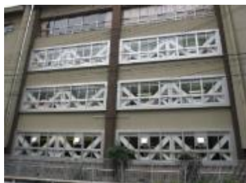
ブレース設置（窓面）
