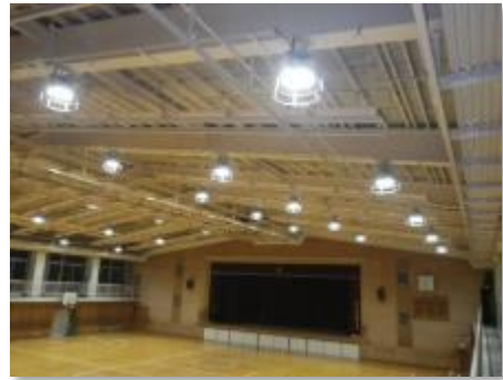
<脱落対策後> 天井撤去による対策
