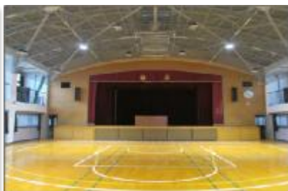
ブレース設置（屋根面）
