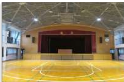
ブレース設置（屋根面）
