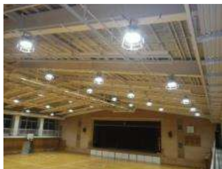
<脱落対策後> 天井撤去による対策
