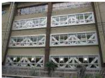
ブレース設置（窓面）
