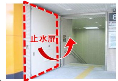
止水扉の設置事例
