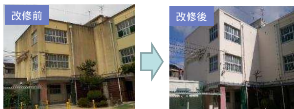
市設建築物の長寿命化事例(外壁改修)
