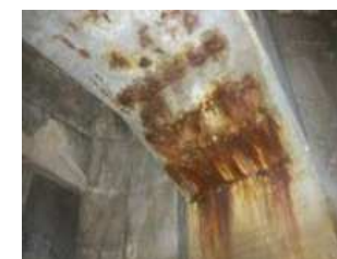
劣化が進行している係留施設(岸壁、物揚場)等の補修
