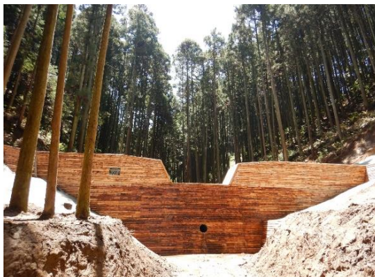
治山ダムの整備
