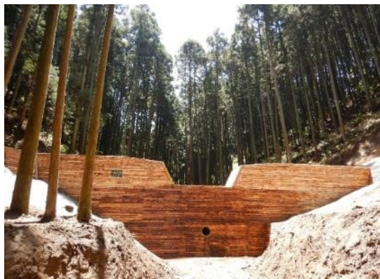
治山ダムの整備
