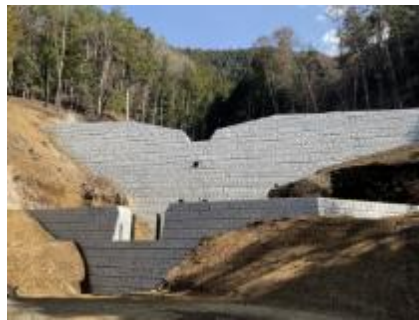
治山ダム(流域治水対策型)の設置
