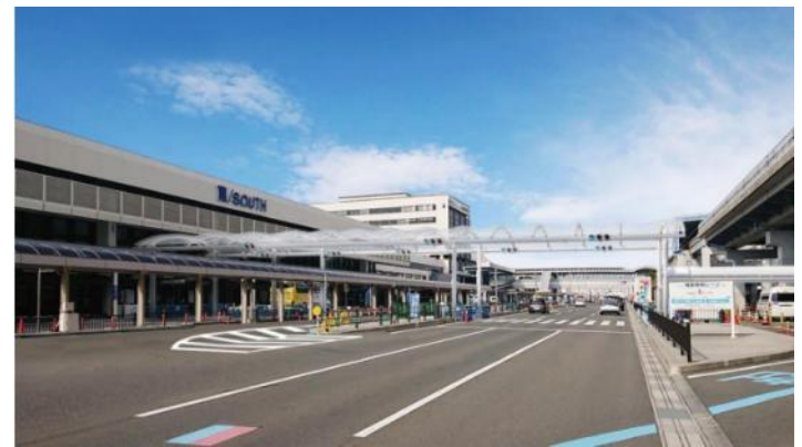
ターミナルビル前面の横断歩道に設置
