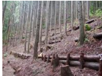
本数調整伐と筋工の施工
