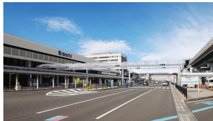
ターミナルビル全面の横断歩道に設置
