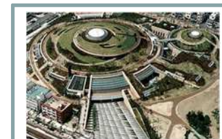
計画的な維持管理と安全確保のための大規模改修 中央体育館(~R7)
