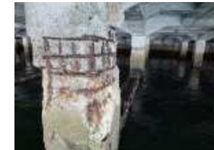
劣化が進行している係留施設(岸壁、物揚場)等の補修
