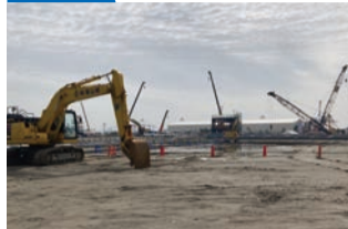
建築工事の様子
