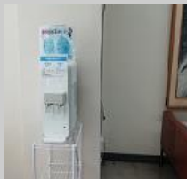
給水機の設置
