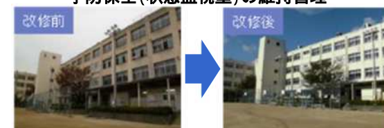
長寿命化事例(外壁改修等)
