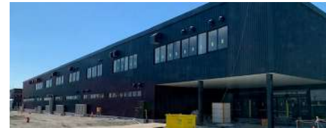
会場衛生監視センターが入る管理棟
