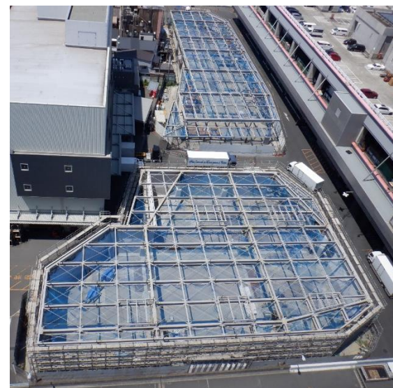
建設予定地(令和4年8月1日現在)
