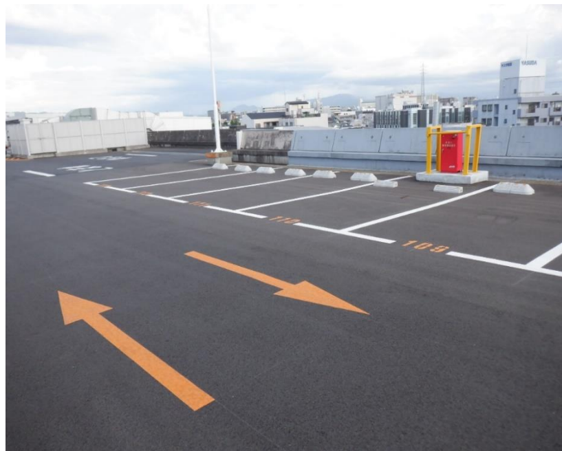
仲卸売場棟屋上（水産側）
