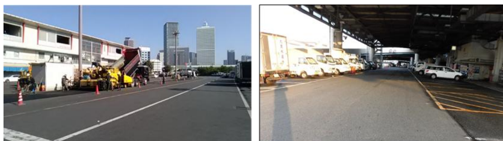
【 正面通路（路面舗装） 】
