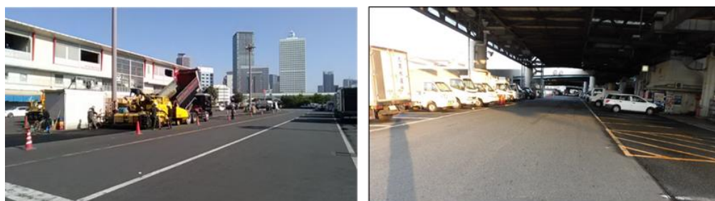
【 正面通路（路面舗装） 】
