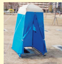
マンホールトイレ 災害時、仮設トイレ用排水管路にあるマンホールの上に仮囲いを設け、トイレ機能を確保します
