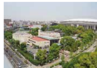
長居障がい者スポーツセンター外観
