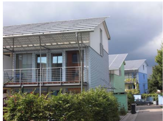
プラスエネルギー方式の集合住宅
