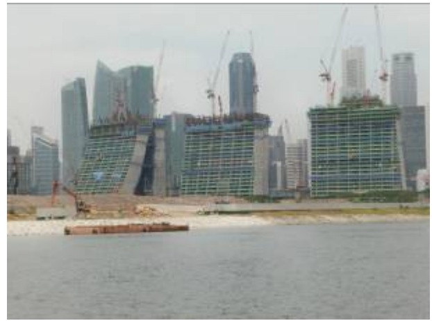
カジノ付きホテルの建設状況
