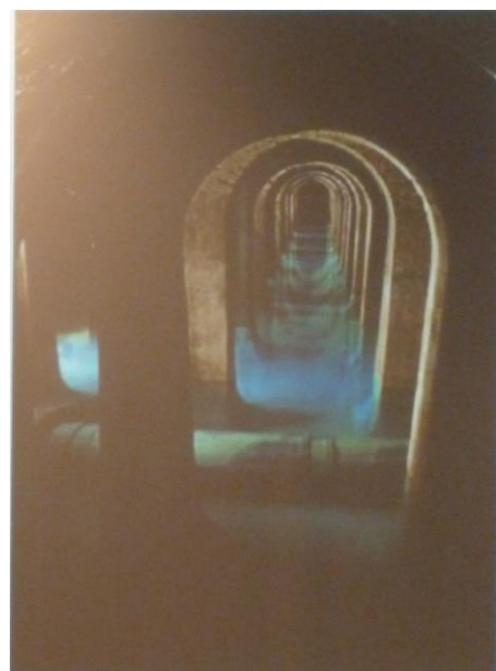
人が入れる下水道を通る水道管
