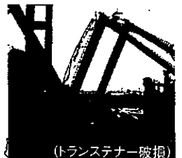
(トランスレーナー破損)
