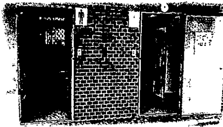
トイレを改修
