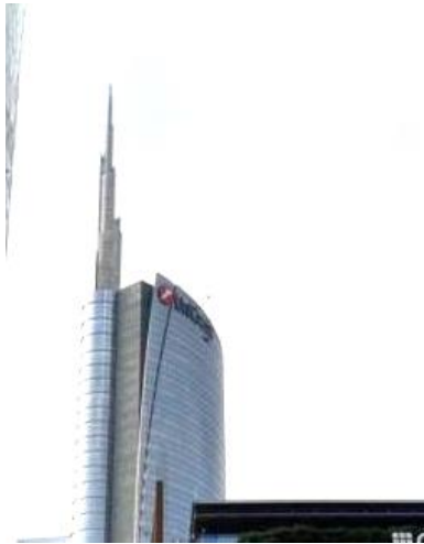
奥のビルはイタリアで最も高い建築であるユニクレディットタワー。
