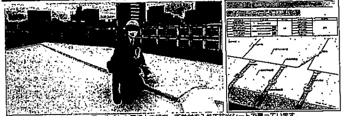
令和5年2月7日、完成した屋根上を視察。断熱材を入れて防水シートで覆っています。
