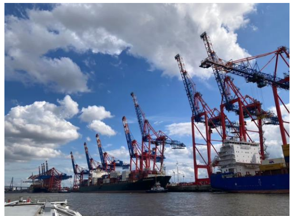
（ガントリークレーンが整備された岸壁）
