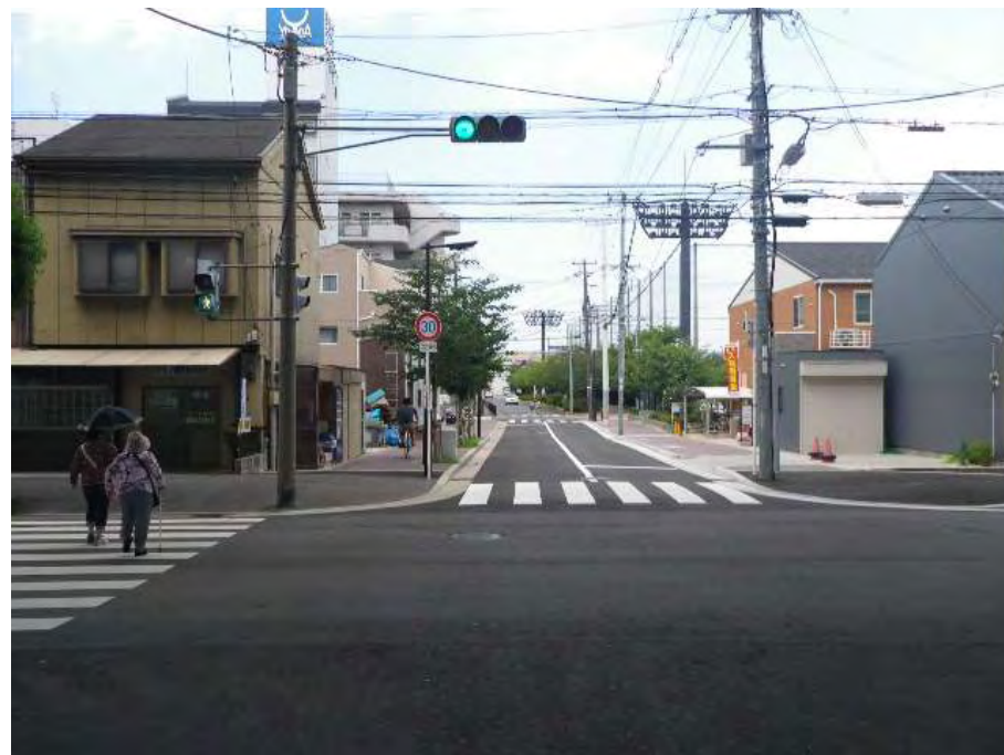
整備完了後(平成23年)
