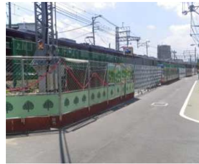
千里線新幹線南側工事状況
