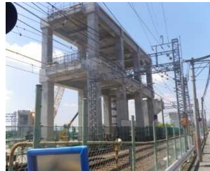
京都線淡路駅南側工事状況
