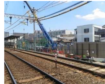
下新庄駅付近工事状況
