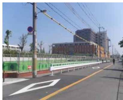
柴島駅付近工事状況
