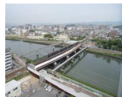
神崎川仮線橋梁
