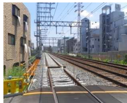
京都線終点方工事状況
