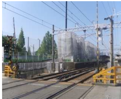
崇禅寺駅付近工事状況
