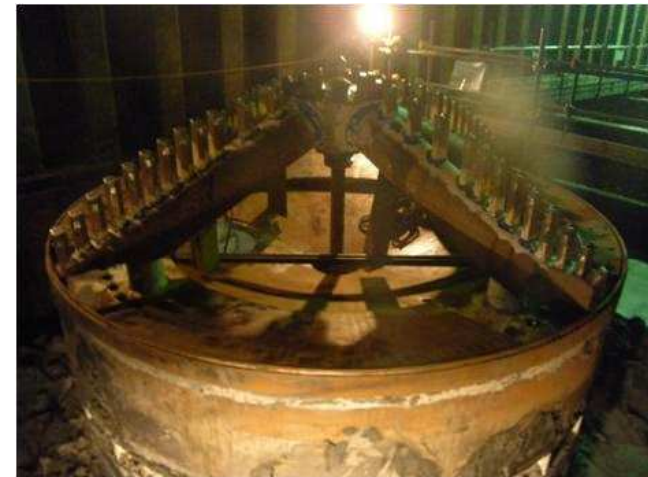
施工時(上向きシールドマシン)
