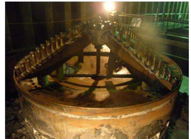
施工時(上向きシールドマシン)
