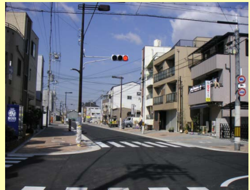
用地を取得し、整備工事を実施
