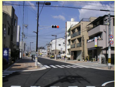
用地を取得し、整備工事を実施
