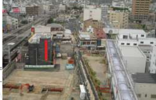
① 従前居住者用住宅屋上より地区東側エリア
