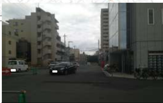
④ 淡路駅前線(東側)の用地確保と仮整備
