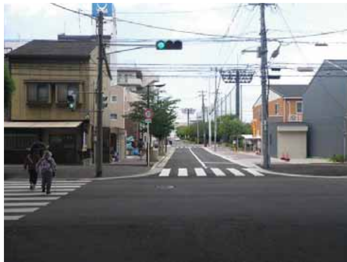
整備完了後(平成23年)
