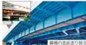
鋼橋の塗装塗り替え
