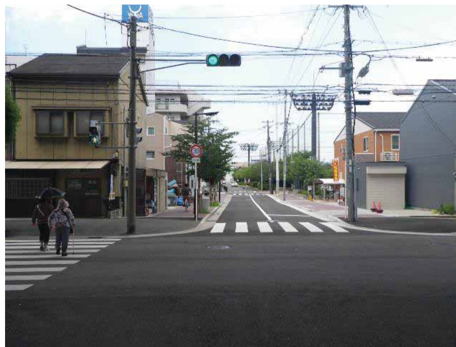
整備完了後(平成23年)
