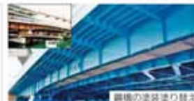
鋼橋の塗装塗り替え
