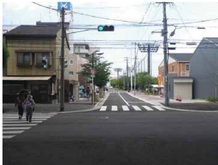
整備完了後(平成23年)
