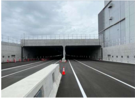
工事状況写真-2 海老江JCT～国道2号
