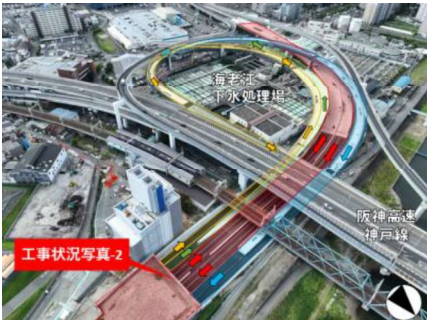
工事状況写真-1 海老江JCT部
