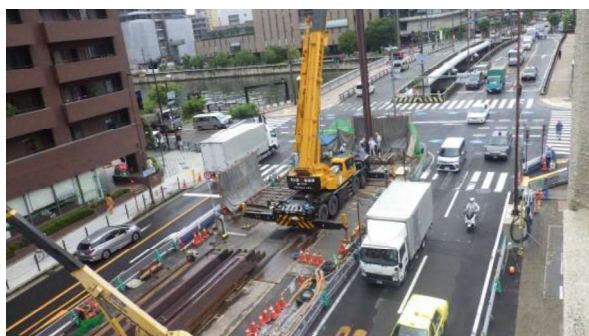
(仮称) 中之島駅部：土留壁工事中
