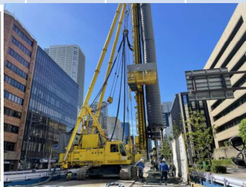
(仮称) 西本町駅部：土留壁工事中
