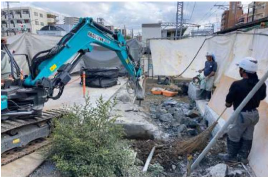
【7工区】下新庄踏切付近
