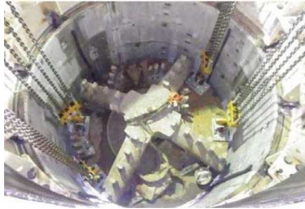
内筒部吊り下ろし状況
