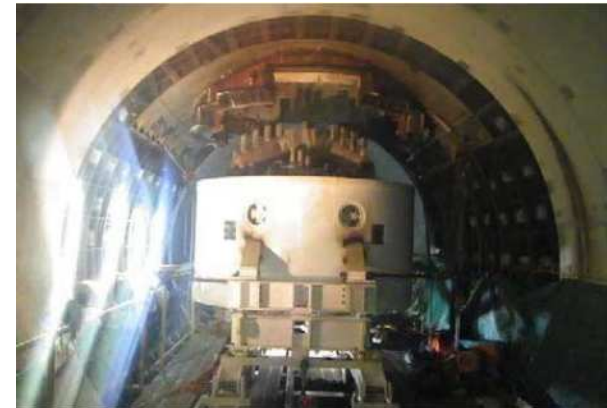
本線トンネル内 外筒部と内筒部再接続
